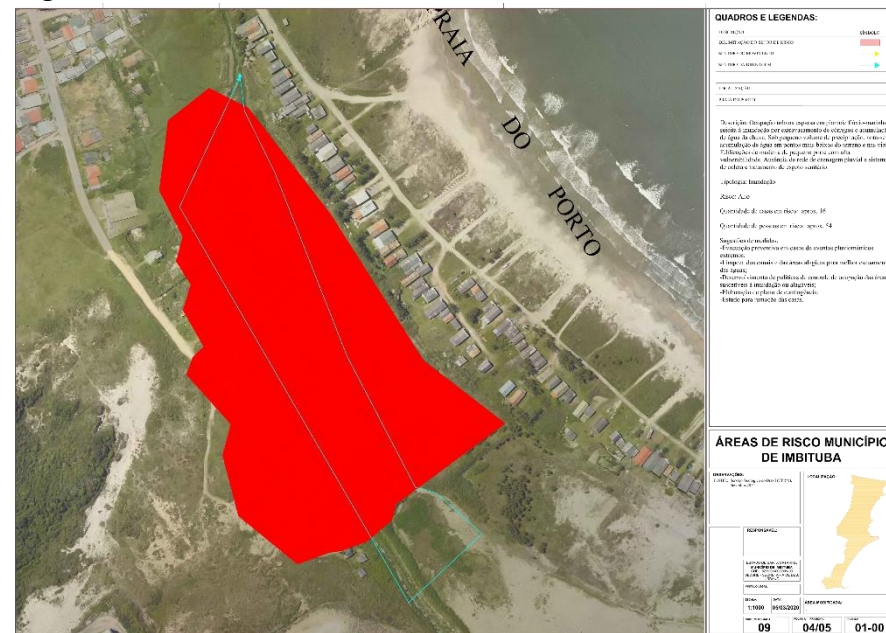
Figura 06d - Áreas de risco em Imbituba
