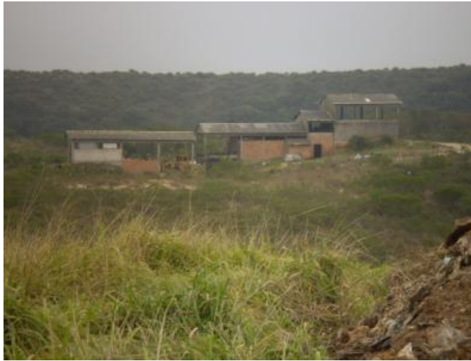
Figura 121: Vista lateral do Centro de Triagem.
