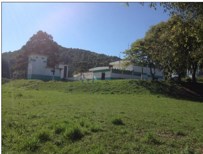
Figura 69: Vista da ETA.
