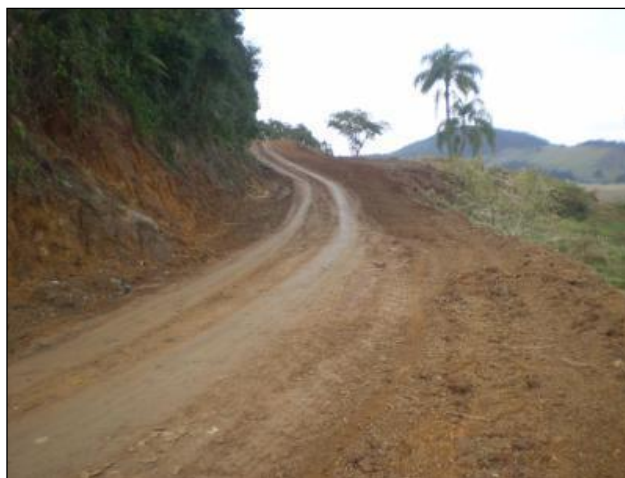
Figura 35: Estrada de Acesso a Captação no Rio D'Una.
