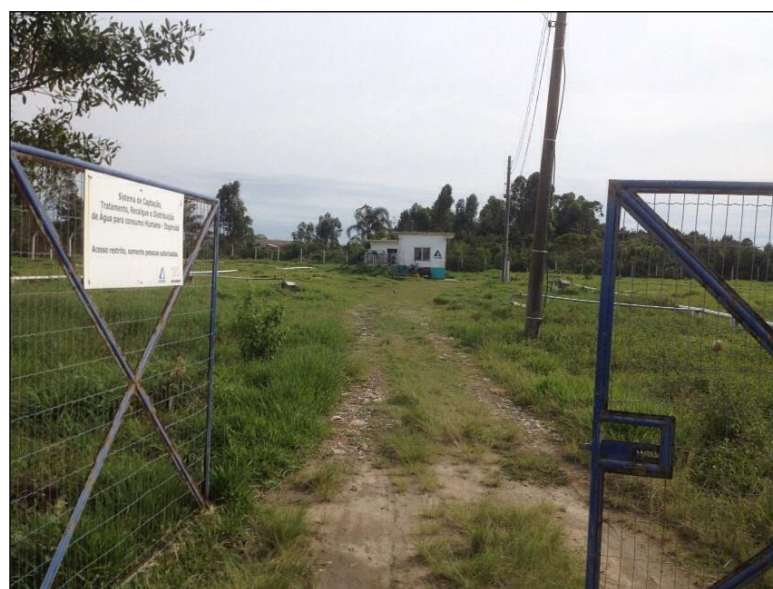
Figura 80: Entrada da Estação de Tratamento Simplificado (Boa Vista).
