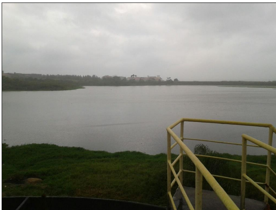
Figura 109: Localização e Vista da ETE Paes Leme.
