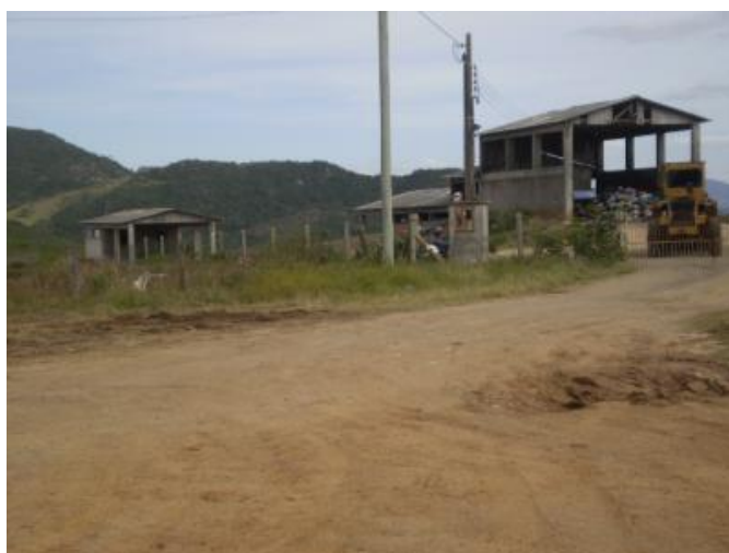
Figura 120: Vista frontal do Centro de Triagem.
