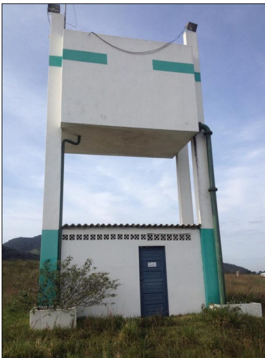
Figura 94: Vista do reservatório R5.
