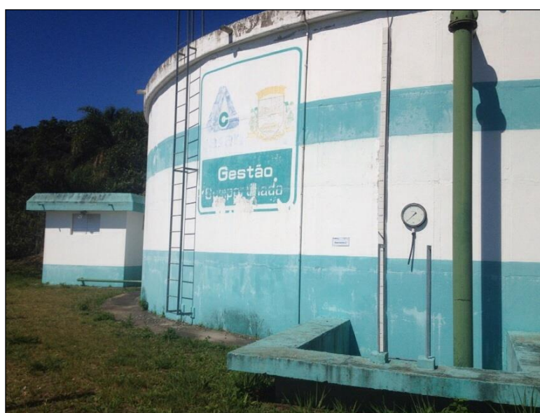
Figura 97: Vista do reservatório R7.
