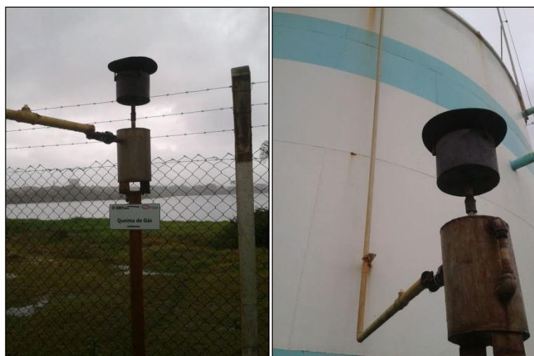
Figura 113: Queimador desativado
