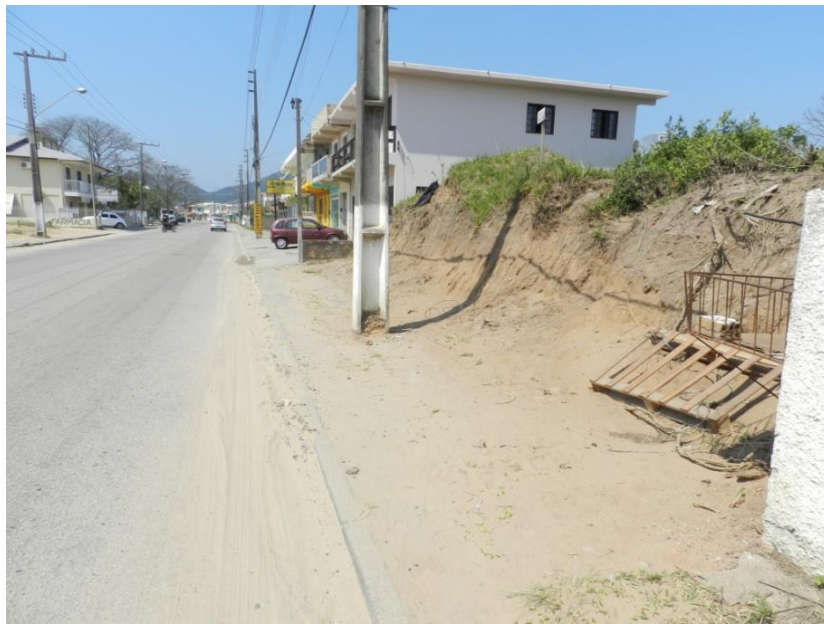
Figura 155: Presença de sedimentos no sistema de drenagem (sarjeta) - Rua Itamar Luiz da Costa
