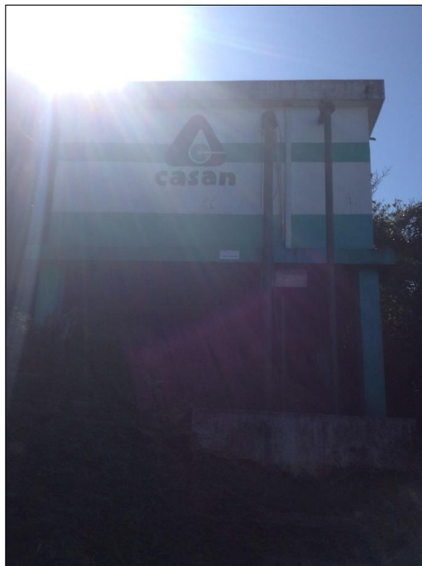
Figura 98: Vista do reservatório R8.
