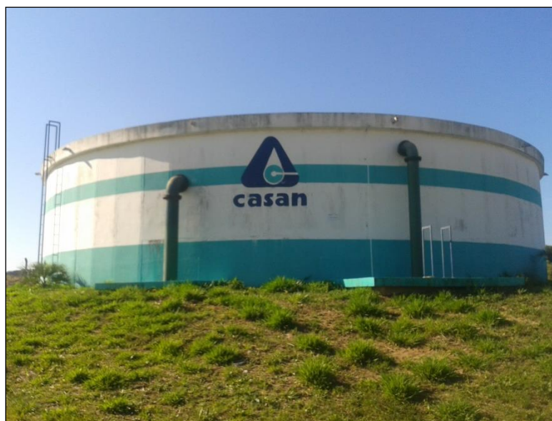
Figura 96: Vista do reservatório R6.
