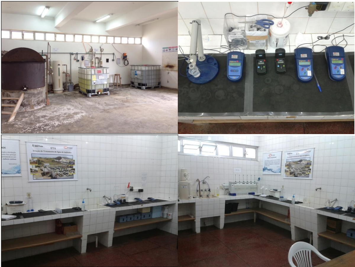
Figura 71: Melhorias realizadas na casa de química.
