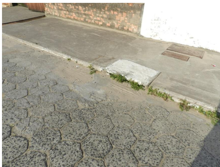
Figura 165: Caixa coletora na Rua Florestal.
