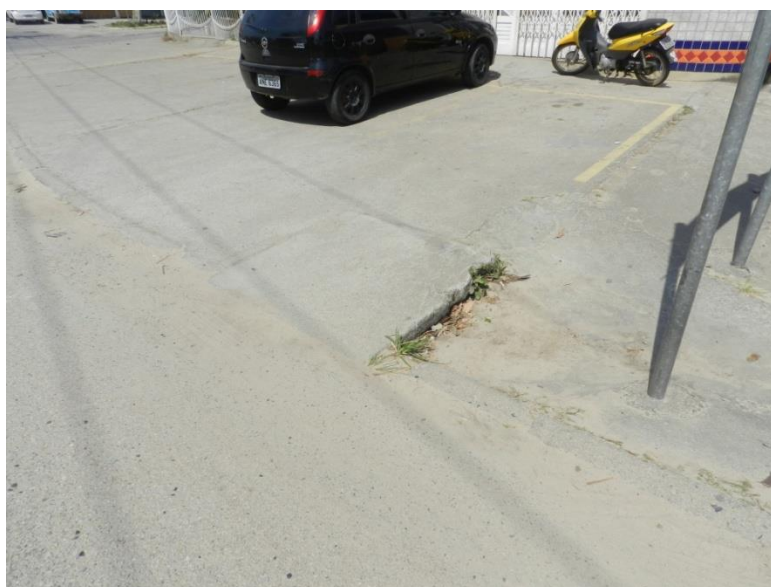
Figura 168: Caixa coletora na Rua Itamar Luiz da Costa.
