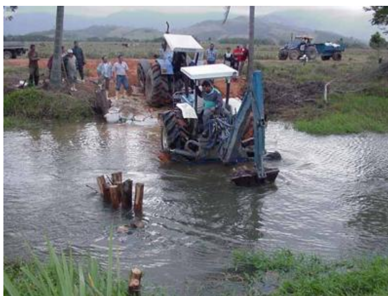
Figura 58: Construção da Barragem.
