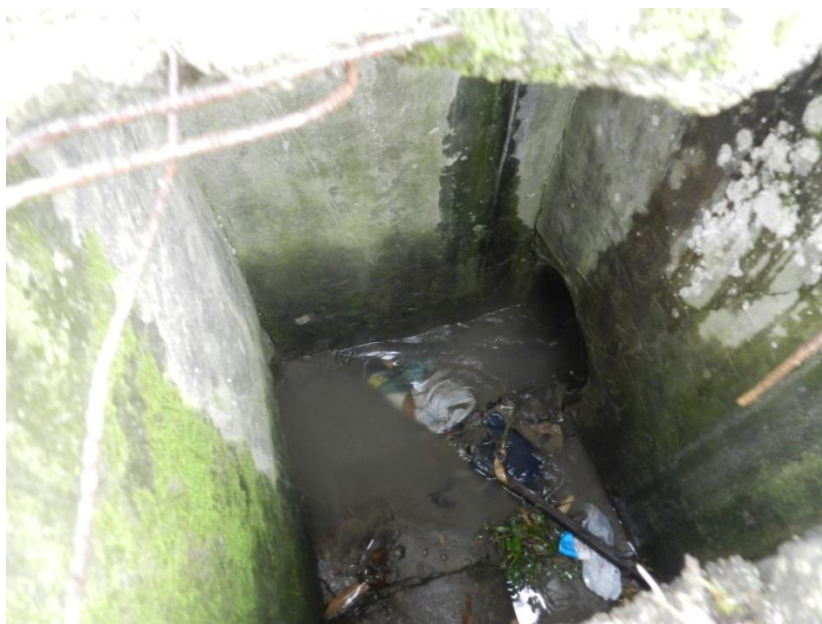
Figura 153: Presença de resíduo Sólido (Rua João de Carvalho).
