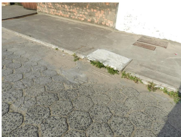
Figura 165: Caixa coletora na Rua Florestal.
