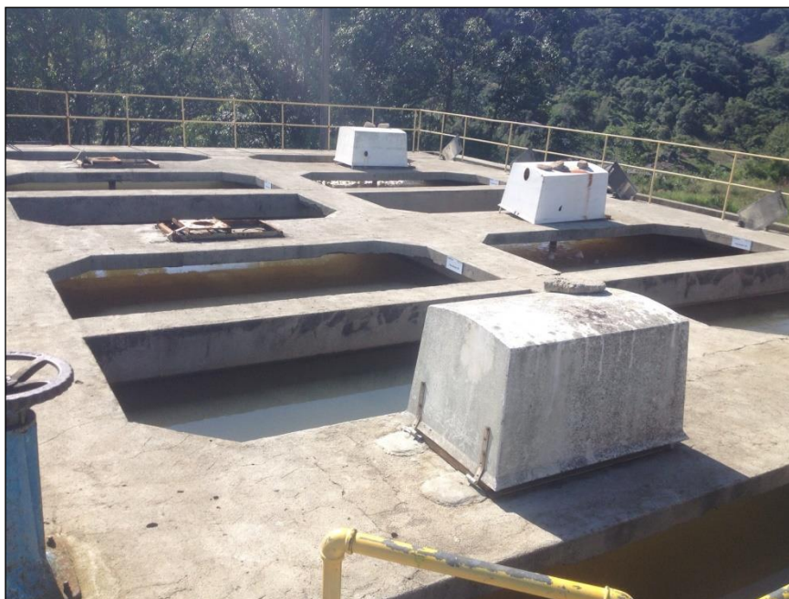
Figura 74: Flocculação Mecanizada: proporciona maior flexibilidade operacional, permitindo a variação de gradientes de velocidade, através do uso de conversores de frequência nos agitadores.
