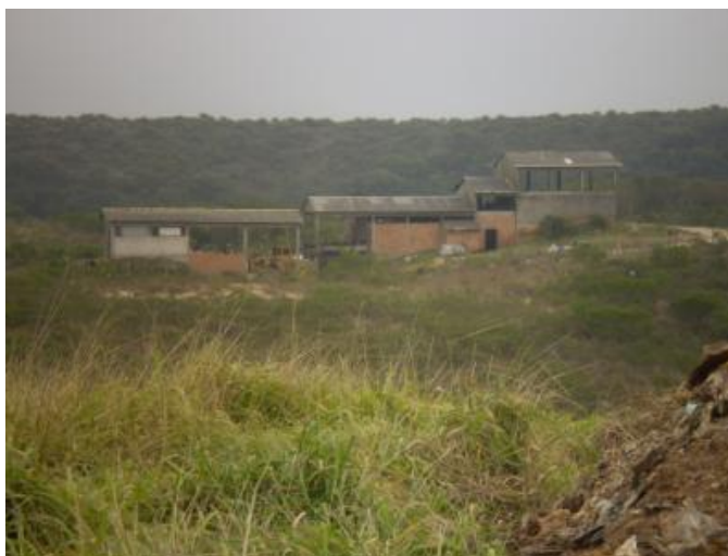
Figura 121: Vista lateral do Centro de Triagem.
