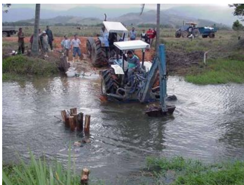
Figura 58: Construção da Barragem.
