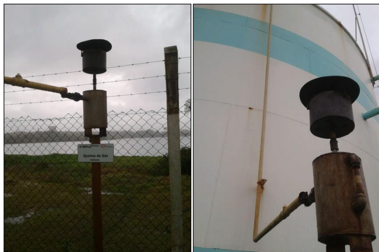
Figura 113: Queimador desativado
