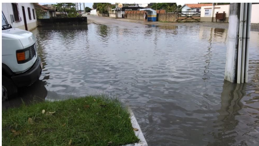
Figura 160: Alagamento na Praça da Igreja – 2
