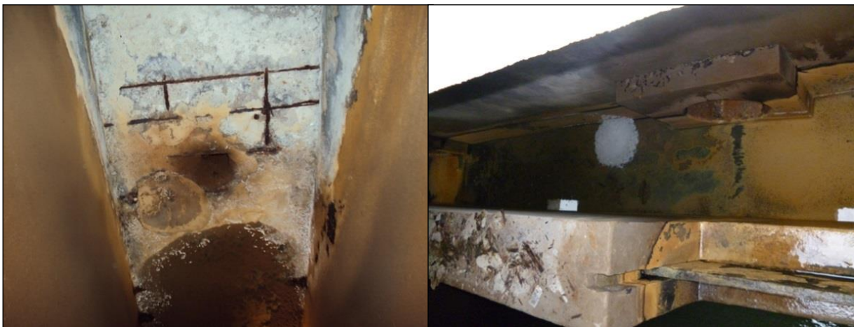
Figura 77: Vista dos filtros e detalhes das condições de conservação.
