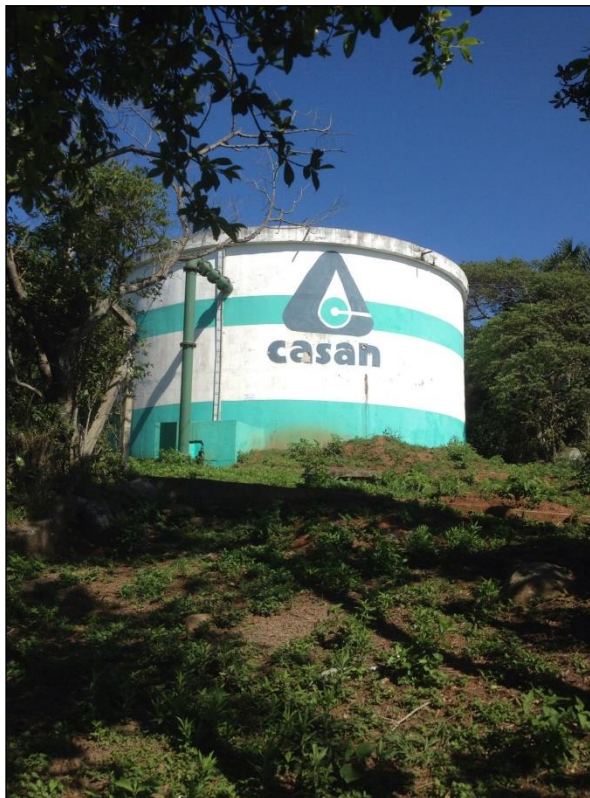
Figura 99: Vista do reservatório R9.
