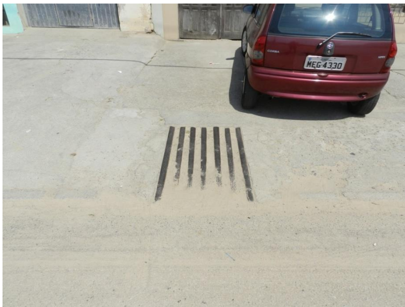
Figura 169: Caixa coletora na Rua Itamar Luiz da Costa.
