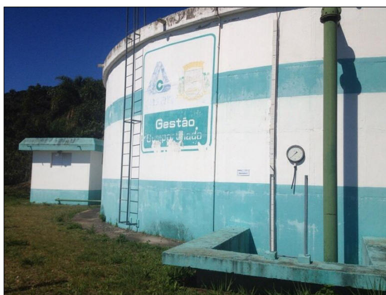
Figura 97: Vista do reservatório R7.
