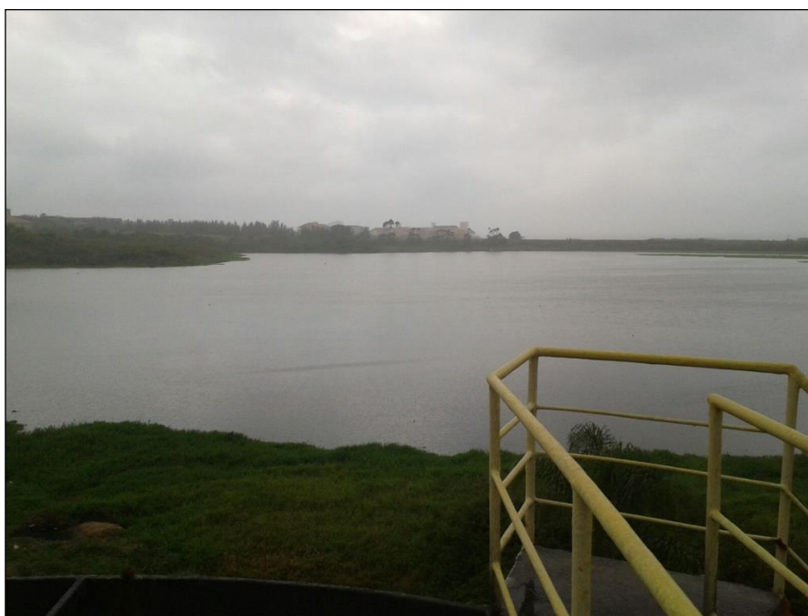
Figura 109: Localização e Vista da ETE Paes Leme.
