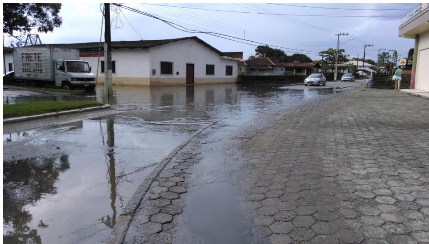
Figura 159: Alagamento na Praça da Igreja -1
