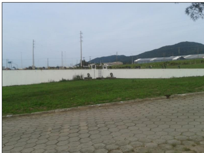
Figura 91: Vista do reservatório R3.
