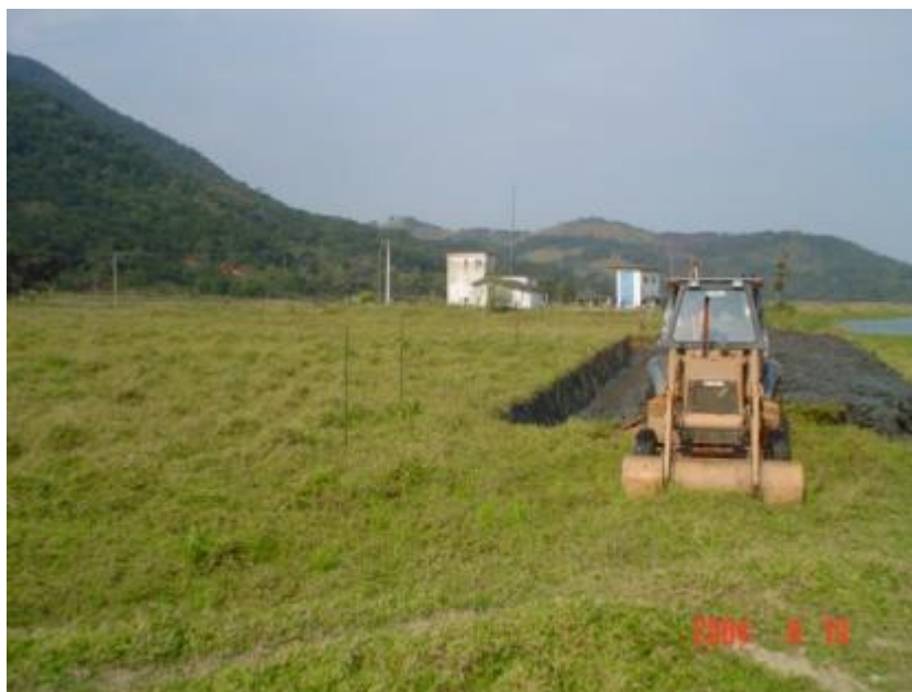
Figura 57: Construção do Canal.
