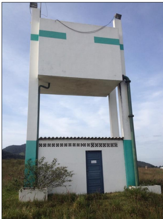
Figura 94: Vista do reservatório R5.
