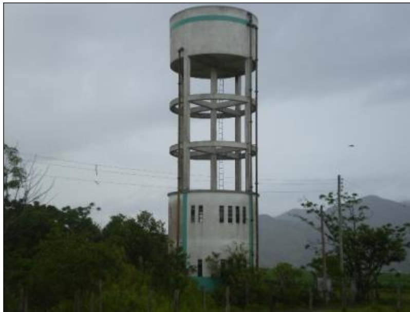
Figura 102: Vista do reservatório de Araçatuba (Desativado).
