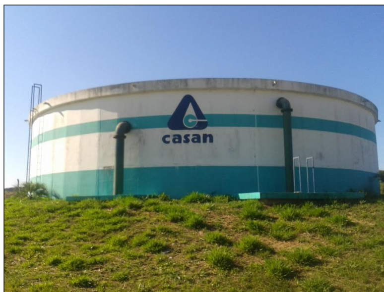
Figura 96: Vista do reservatório R6.
