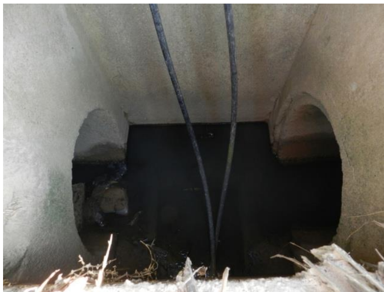
Figura 171: Passagem das galerias por dentro das caixa coletoras na Rua Itamar Luiz da Costa
