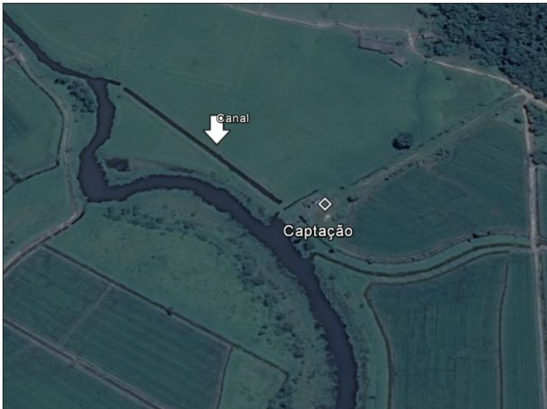
Figura 32: Ponto de captação de Água rio D'una com canal.
