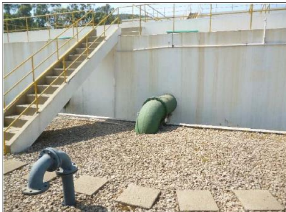
Figura 95: Vista do reservatório R5-A.
