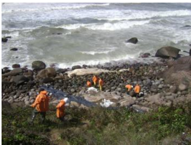
Figura 138: Operação de Remoção do Material.
