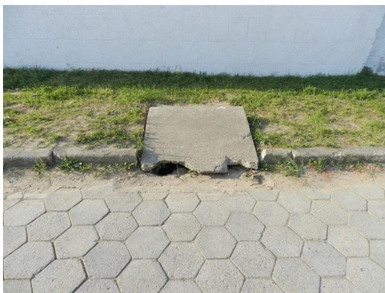
Figura 163: Caixa coletora na Rua Santa Catarina.
