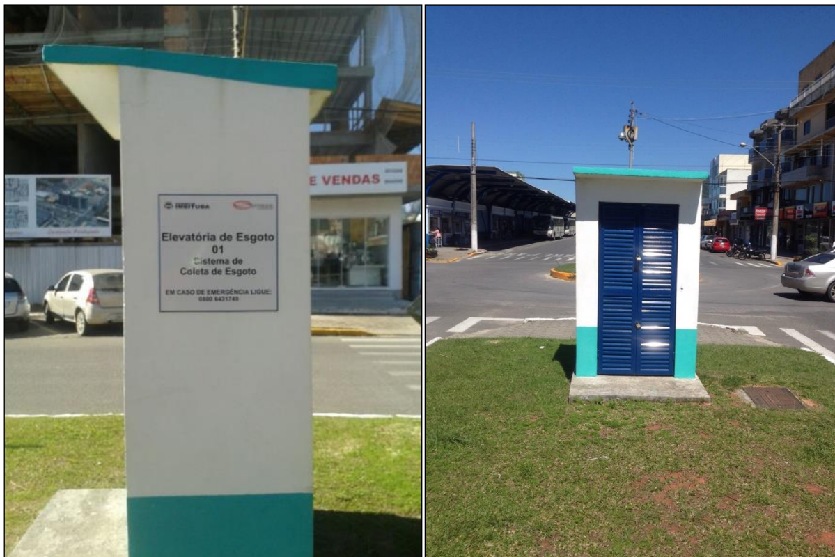
Figura 105: Vista da Elevatória de Esgoto EE-5A.
