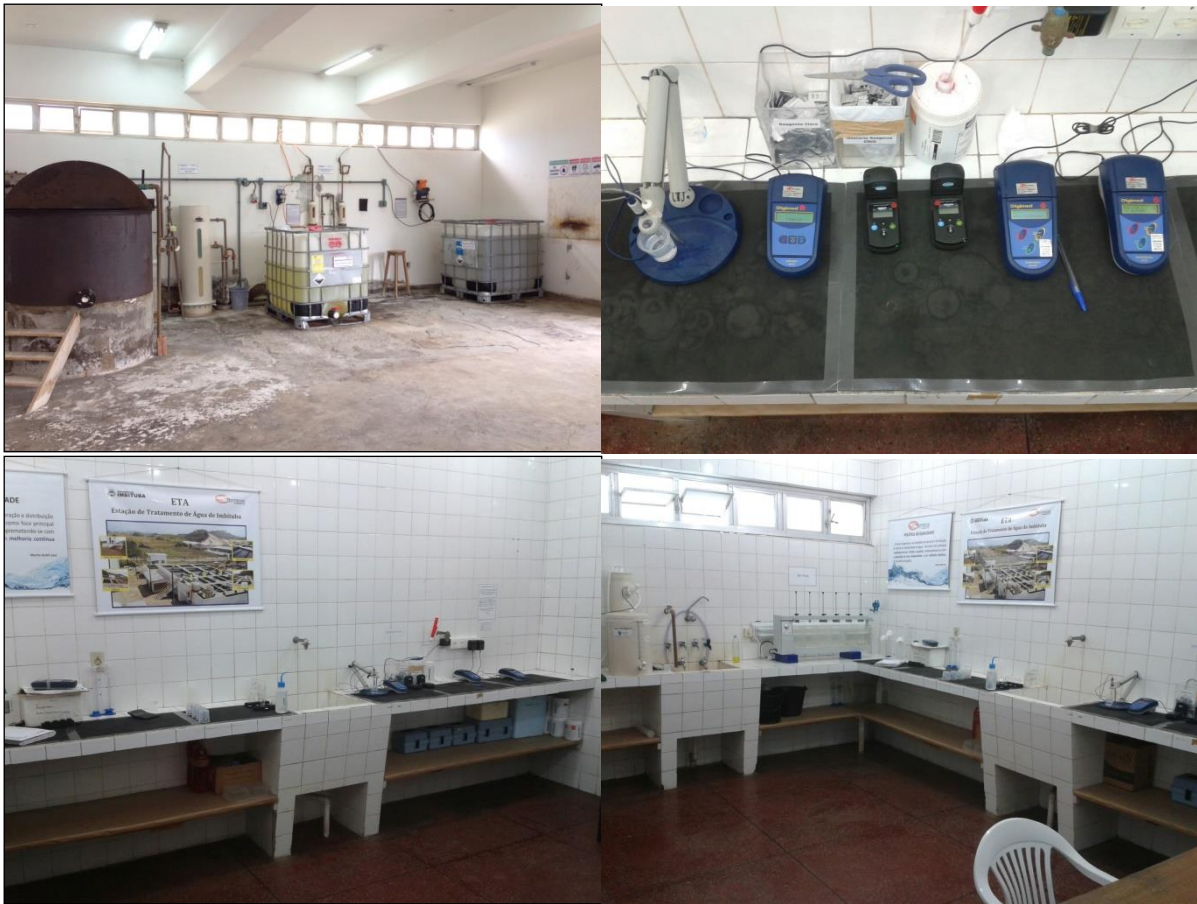
Figura 71: Melhorias realizadas na casa de química.
