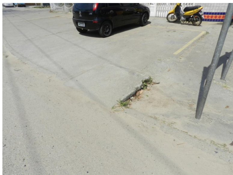
Figura 168: Caixa coletora na Rua Itamar Luiz da Costa.
