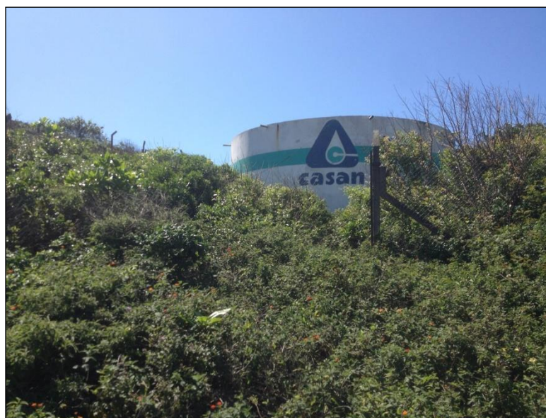
Figura 100: Vista do reservatório R10.
