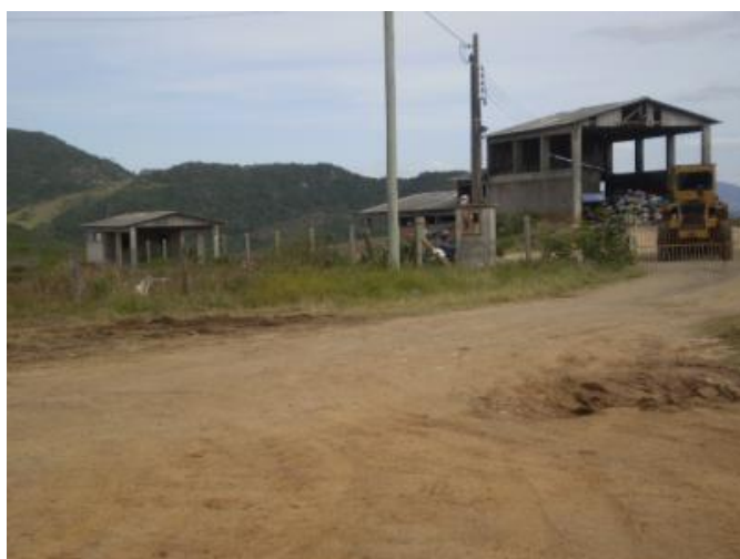
Figura 120: Vista frontal do Centro de Triagem.
