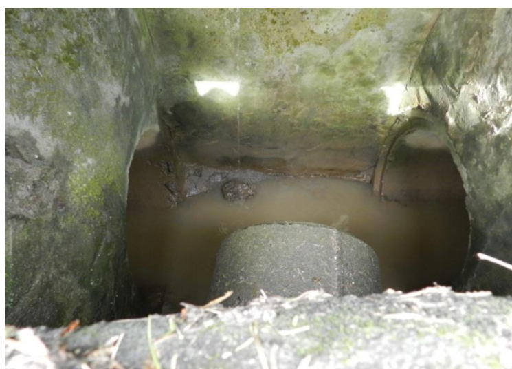
Figura 173: Encontro de três tubulações na caixa coletora
