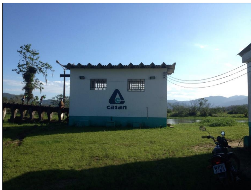
Figura 40: Vista da EEAB Rio D'Una.
