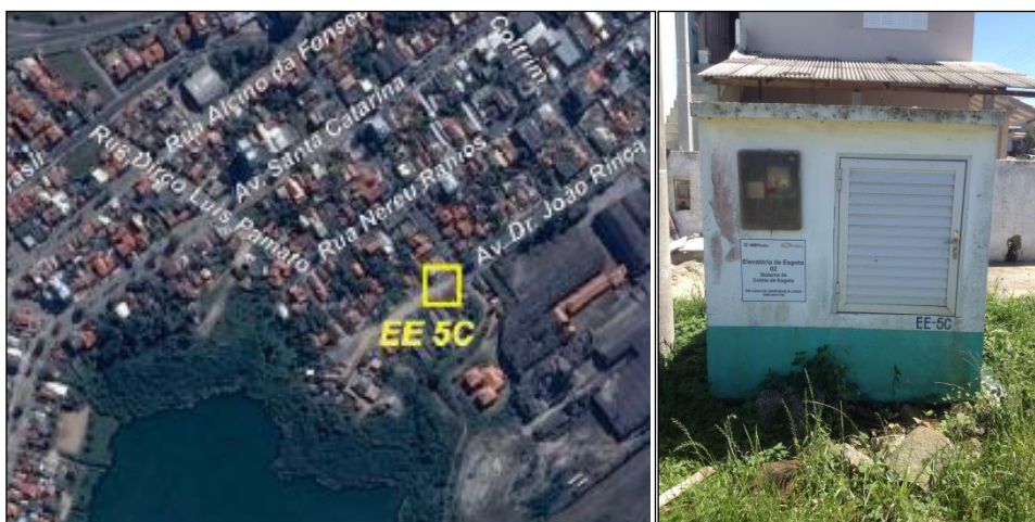
Figura 107: Vista da Elevatória de Esgoto EE-5C e Localização.
